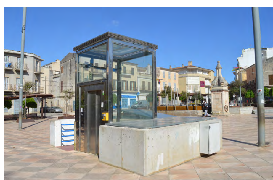
IMATGE DE LA CAIXA DE L'ASCENSOR
