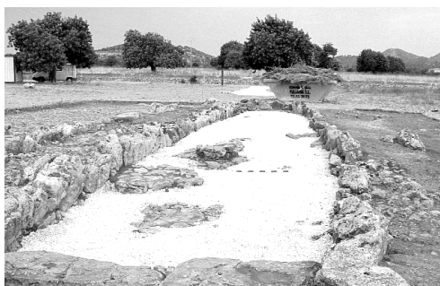
Estat del naviforme 1 una vegada acabades les feines de consolidació i restauració. A l'interior es pot veure per aquest ordre una zona enllosada, una banquetta de pedra i la llar de foc.
