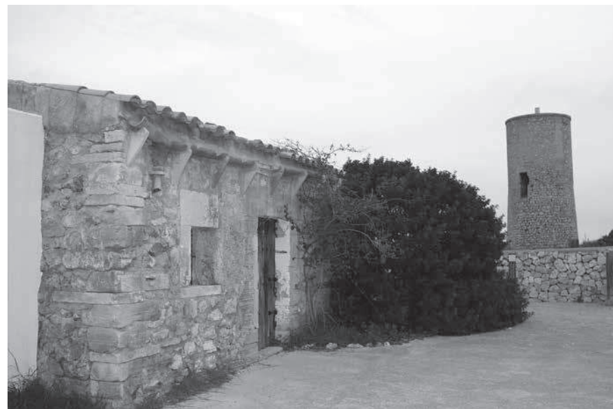
La caseta dels torrers, posterior habitatge de la tropa de la Red de acecho.
