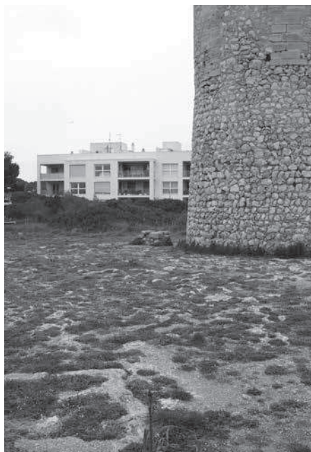
La situació de la base de la garita de vigilància (en primer pla) respecte de la torre.
