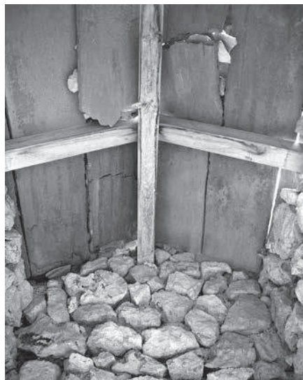
Coberta de la garita vista des de l'interior.
