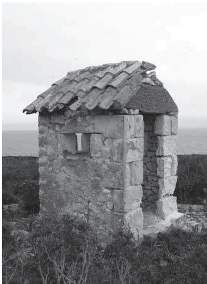
El coster més ben conservat de la garita que fins i tot guarda quasi tota la teulada.
