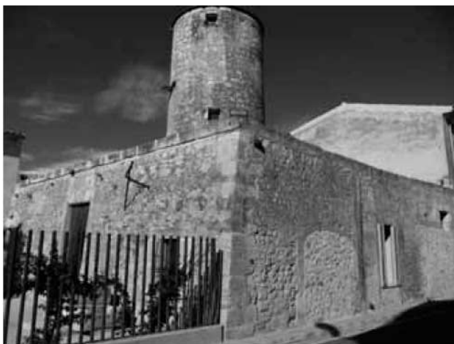
Fig. 4 Estat final després de la intervenció.
